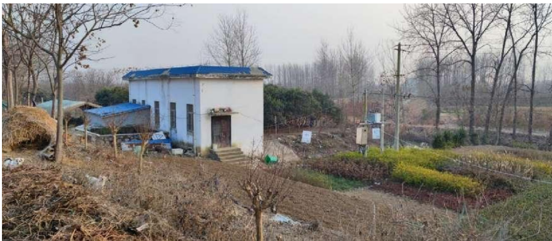
图 3.2-17 虞北站进水立面现状
