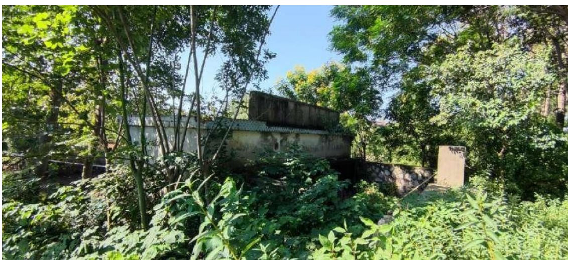
图 3.2-32 贯勤站出水池现状
