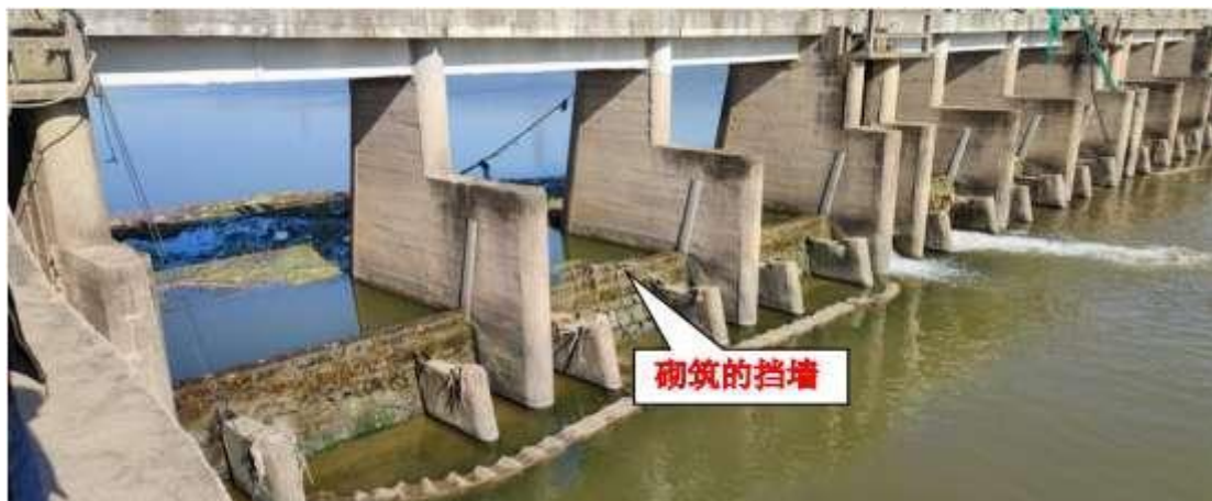
图 3.2-7 袁滩闸闸孔现状
