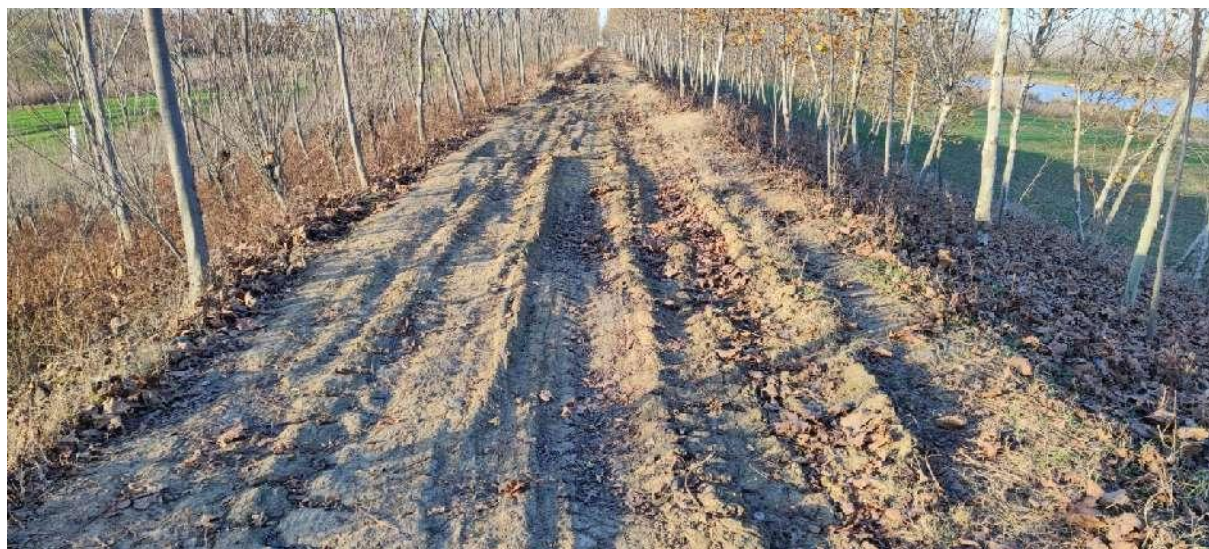
图 3.2-51 现状堤顶土路泥泞、坑洼不平
