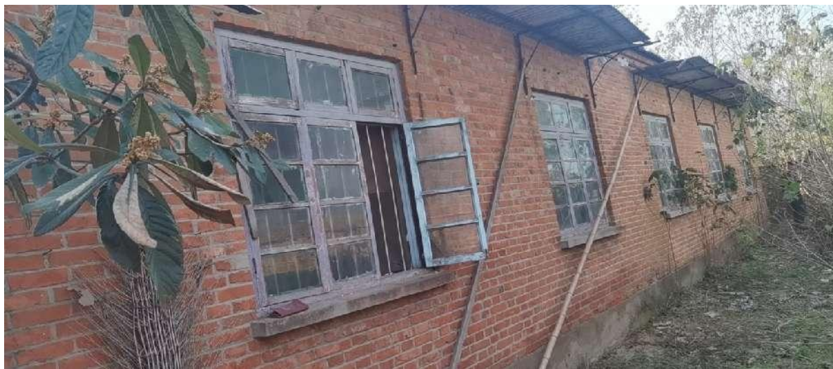
图 3.2-55 管理所外立面现状
