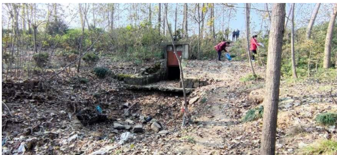
图 3.2-27 徐口站穿堤涵洞出水侧现状
