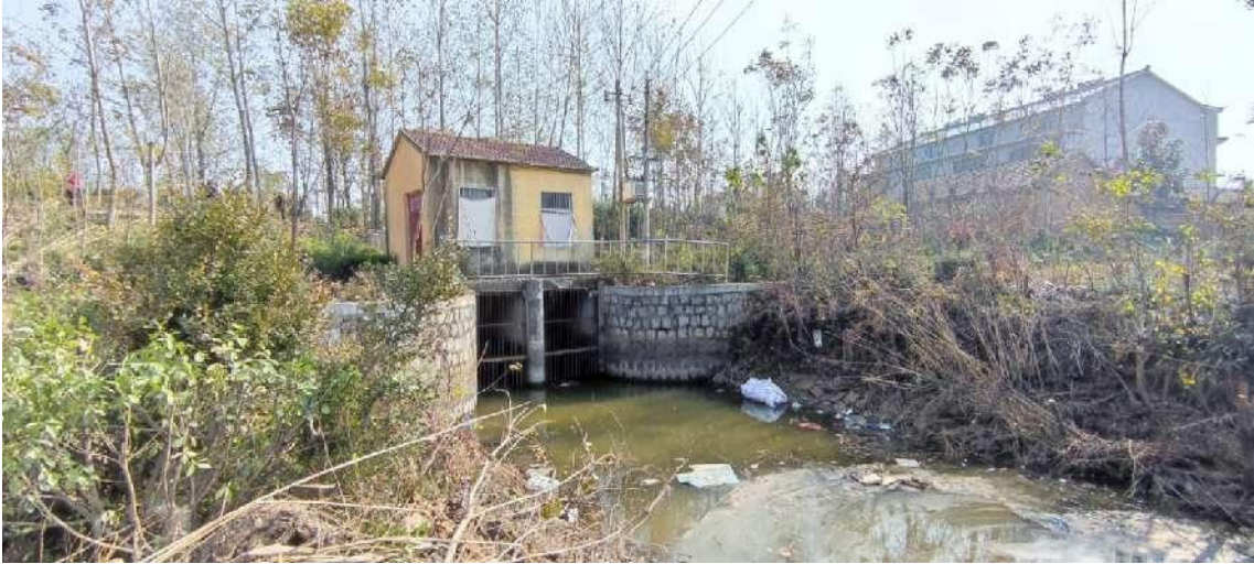
图 3.2-23 徐口站进水侧现状
