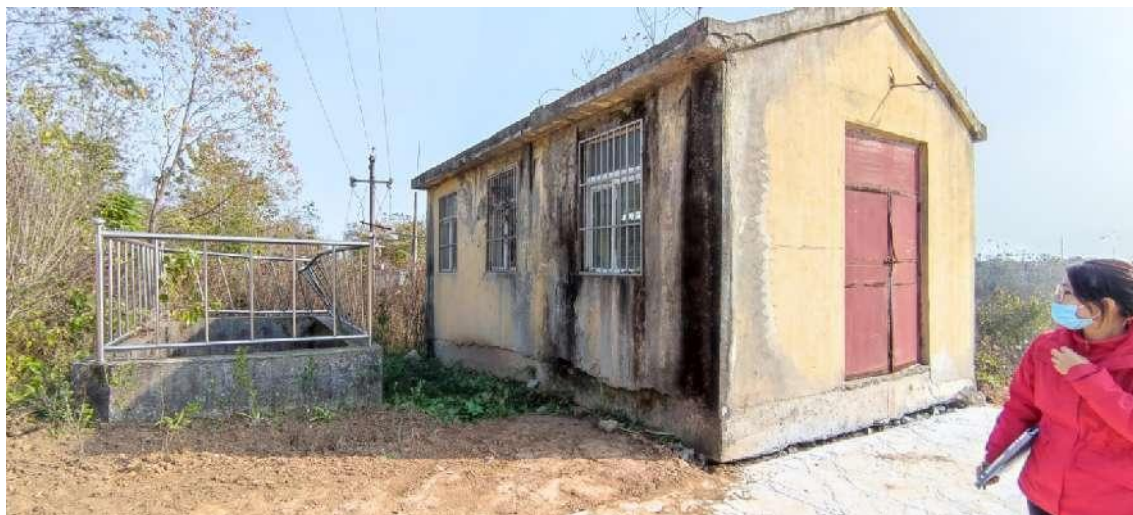
图 3.2-21 段口站出水池侧现状
