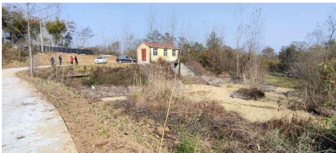
图 3.2-20 段口站进水侧现状
