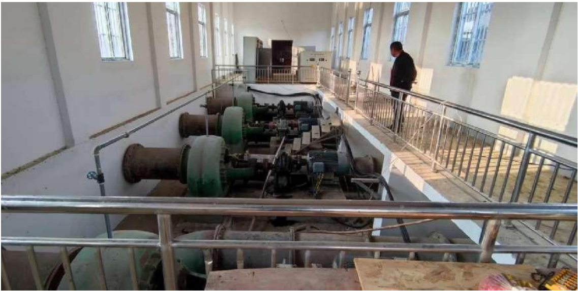
图 3.2-13 项宅站室内现状
