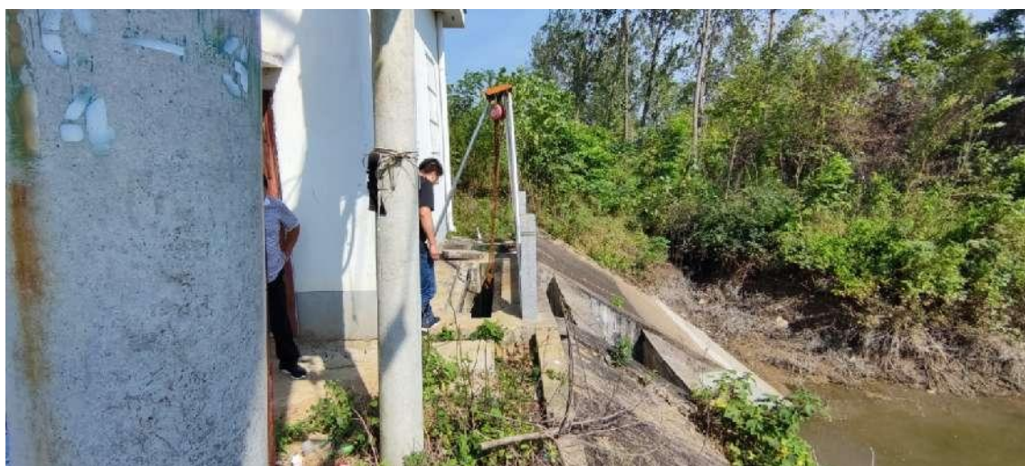
图 3.2-33 张愚站进水侧现状
