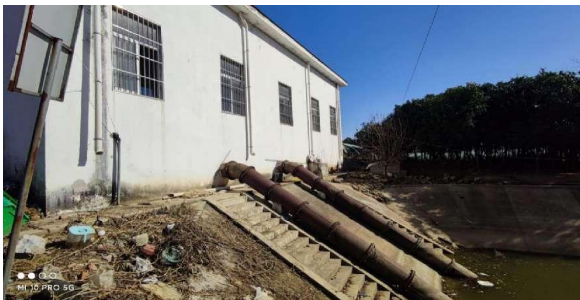
图 3.2-16 虞北站进水立面现状
