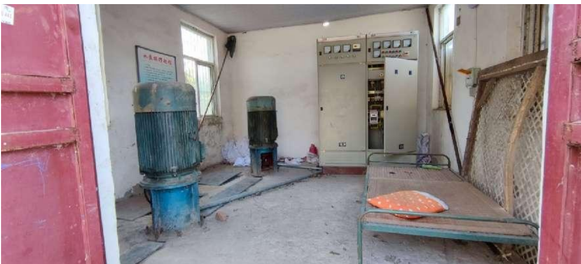
图 3.2-25 徐口站泵室内现状
