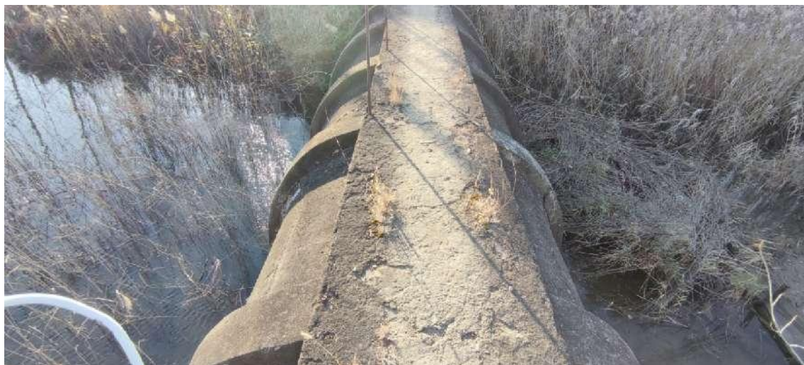
图 3.2-11 吴滩排涝站现状出水涵管
