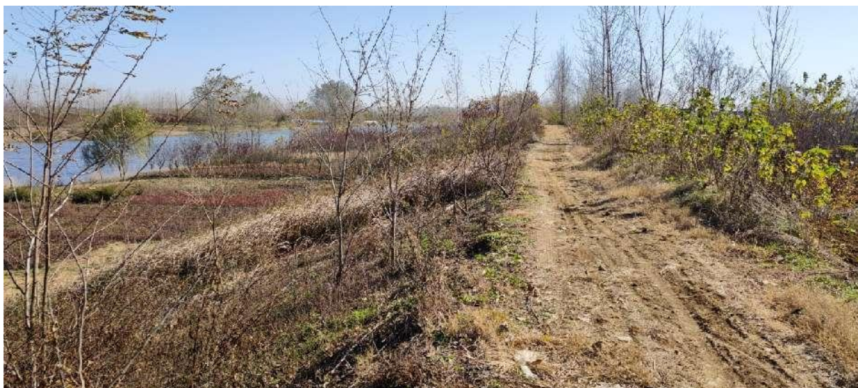
图 3.2-52 现状堤顶土路狭窄段
