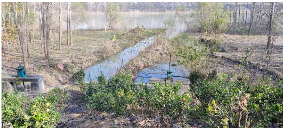
图 3.2-29 王庄站出水侧现状
