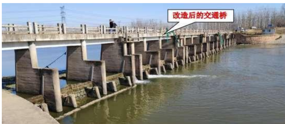
图 3.2-8 袁滩闸下游立面现状
