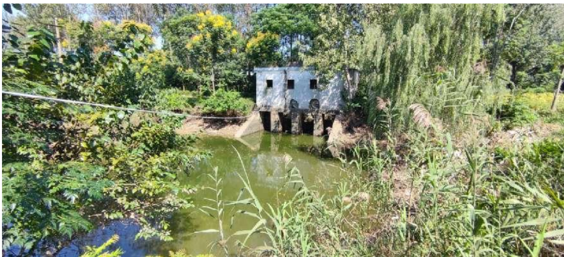
图 3.2-30 贯勤站进水侧现状
