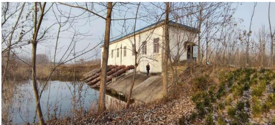
图 3.2-9 吴滩排涝站进水侧立面
