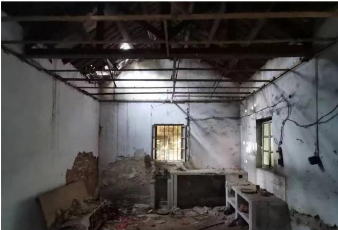
图 3.2-56 管理所房屋内部情况
