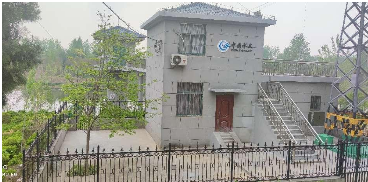
图 3.2-57 水文站缆道房现状
