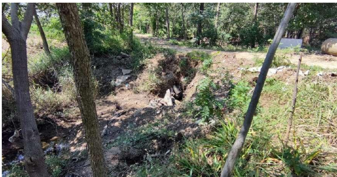
图 3.2-45 吴前圩闸现状
