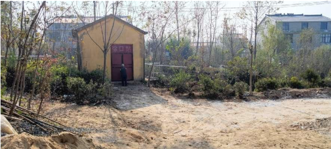
图 3.2-24 徐口站室外现状
