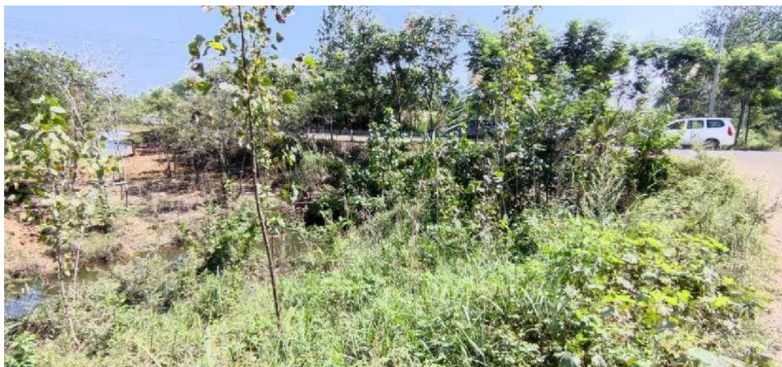
图 3.2-39 虞北沈圩闸现状无节制，容易形成倒灌
