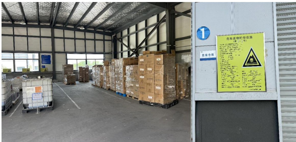
图 3.2.6-3 现有项目危废库照片
